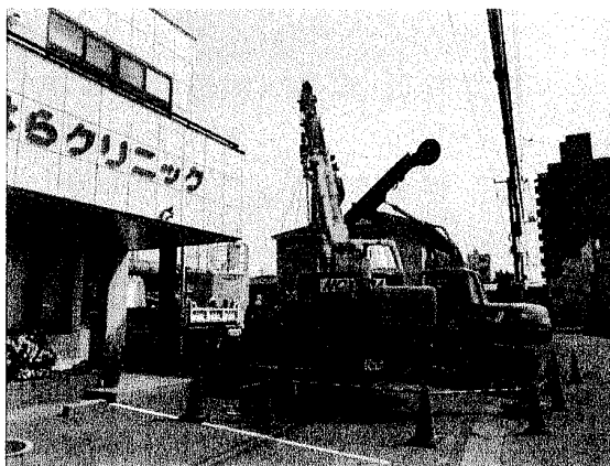
施工状況①
