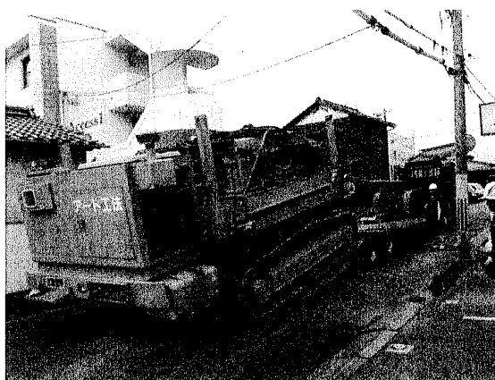
アート機搬入状況
