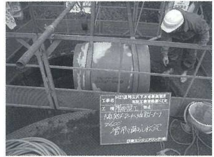
写真-5 管吊下し状況
