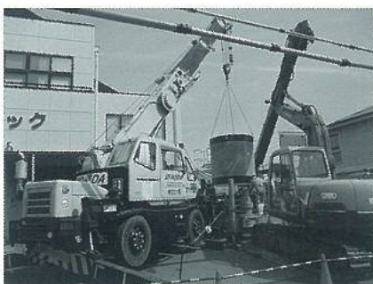
写真-6 施工状況
