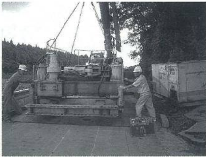
写真-3 アート機設置
